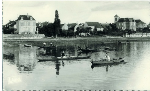
Vue générale du bourg avec la Perraudière
